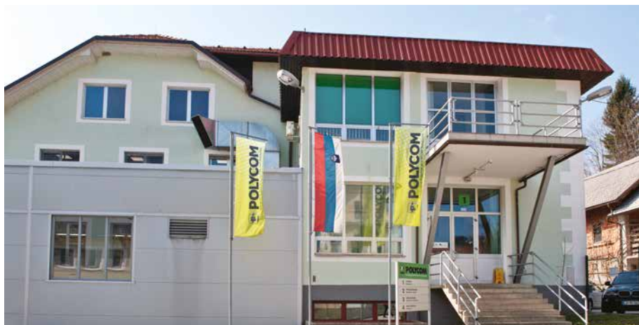
Upravna stavba podjetja Polycom v Škofji Loki
