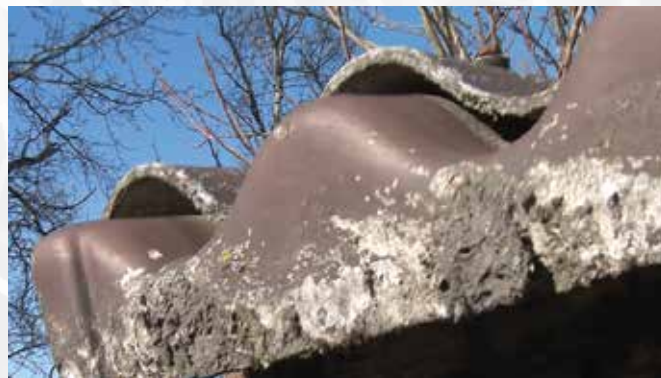
Cvetenje, luščenje azbestcementne kritine
