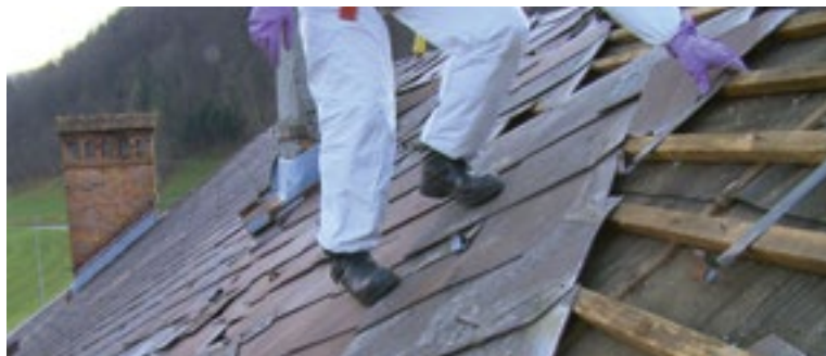
Slika 21: Azbestcementne plošče niso pohodne in pomenijo veliko tveganje za zdrs ali padec 22
