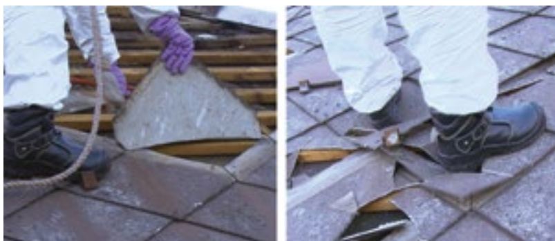
Slika 30: Azbestcementnih plošč pri odstranjevanju ne smemo puliti, lomiti ali kako drugače poškodovati 31
