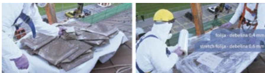
Slika 19: Ovijanje azbestcementnih plošč in manjših odlomljenih kosov s polietilensko ali raztegljivo (stretch) folijo 20
