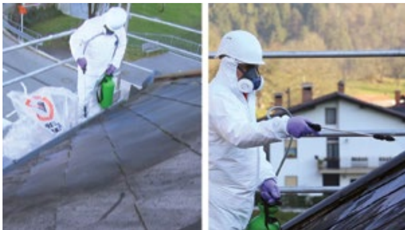
Slika 28: Močenje azbestcemente kritine z razprševanjem ali škropljenjem s pršilci z nizkim pritiskom 29
