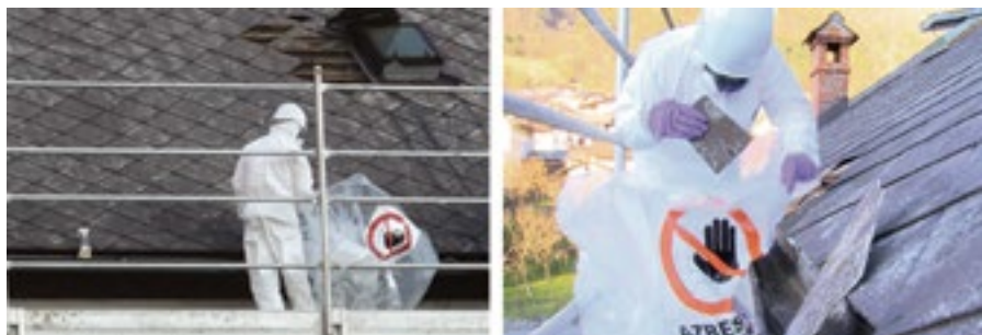
Slika 18: Zbiranje azbestcementnih plošč in manjših odlomljenih kosov na strehi 19
