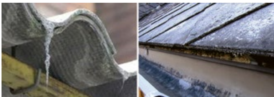
Slika 9: Vidna prisotnost drobljivega ali prašnatega materiala ter vlakna, ki so kot majhni stalaktiti 10
