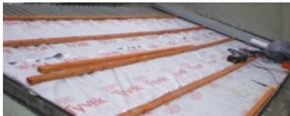
Slika 15: Priprava sekundarnega ogrodja in montaža parne zapore 16
