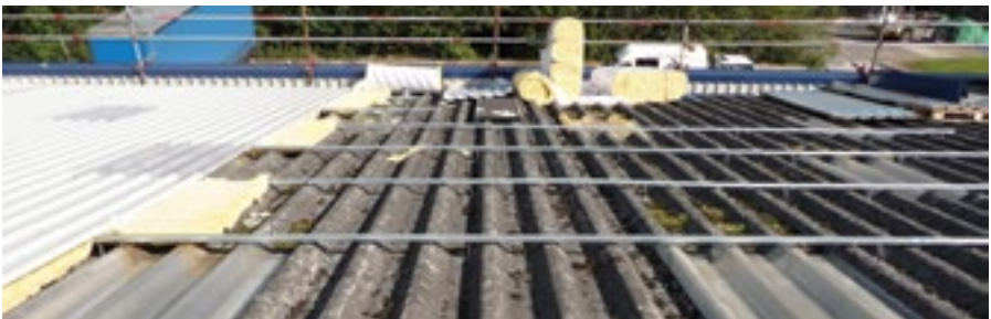
Slika 14: Prekrivanje/nadkrivanje azbestcementne kritine 15
