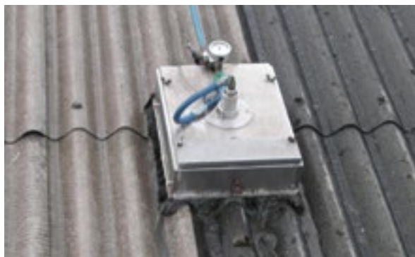
Slika 12: Predhodna priprava (čiščenje) površin 13
