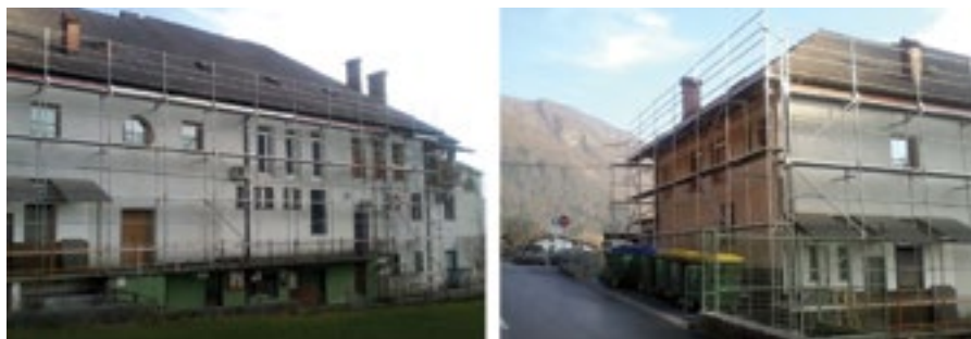
Slika 23: Lovilni odri preprečujejo padec s strehe 24
