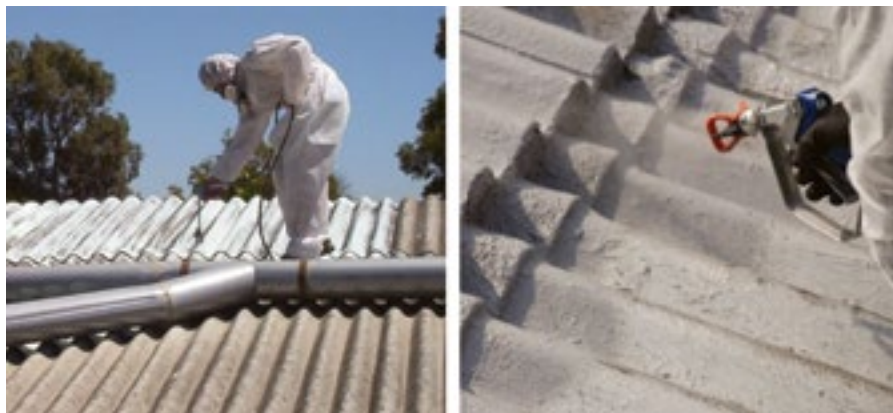
Slika 11: Premazovanje (inkapsulacija, impregnacija) azbestcementne kritine 12
