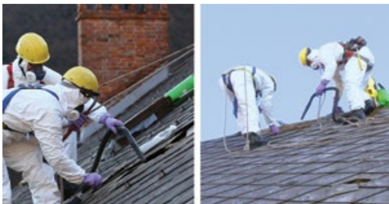
Slika 34: Sesanje kritine s sesalnikom s HEPA-filtr 35
