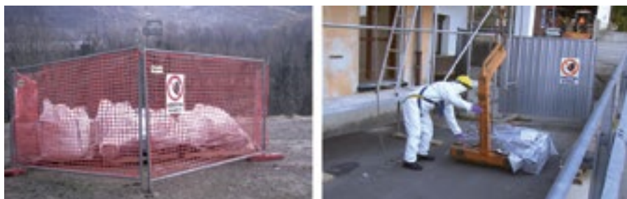
Slika 20: Začasno skladiščenje azbestcementnih odpadkov na ograjenem delu delovišča 21
