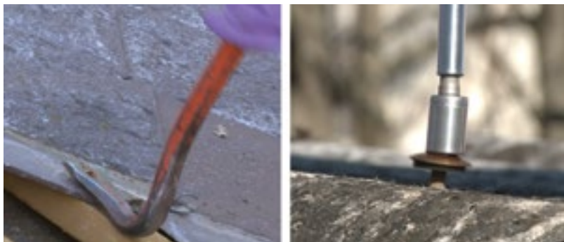
Slika 31: Vijake ali žeblice odstranimo tako, da plošč ne poškodujemo 32
