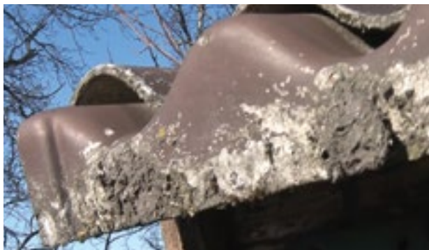
Slika 7: Cvetenje azbestcementne kritine 8
