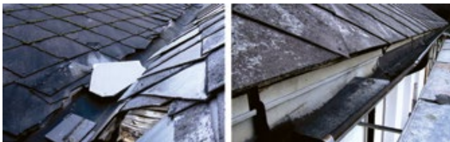
Slika 8: Viden vzdolžni in prečni prelom dotrajane plošče 9
