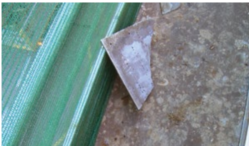
Slika 32: Odstranjenih azbestcementnih plošč ne smemo metati s strehe 33
