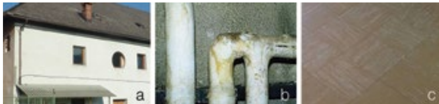
Slika 2: Azbestcementni izdelki: a) kritina 2 , b) vodovodna napeljava, c) talne plošče iz vinil-azbesta »vinaz« 3
