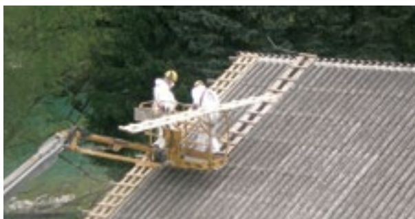
Slika 22: Nameščanje pohodnih elementov 23
